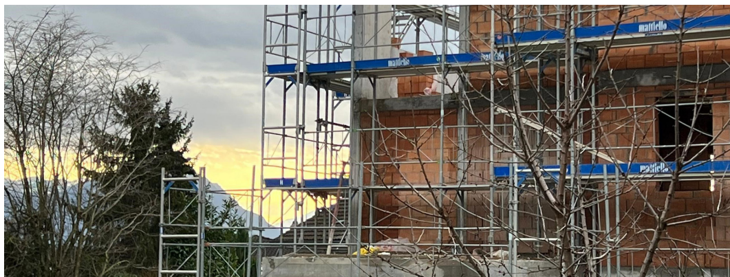
Baustelle im Rheintal, Schweiz
