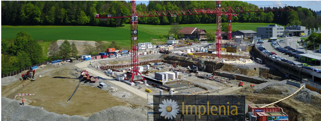
Implenia beim Bau des Campus Sursee (Bildquelle: implenia.com)
