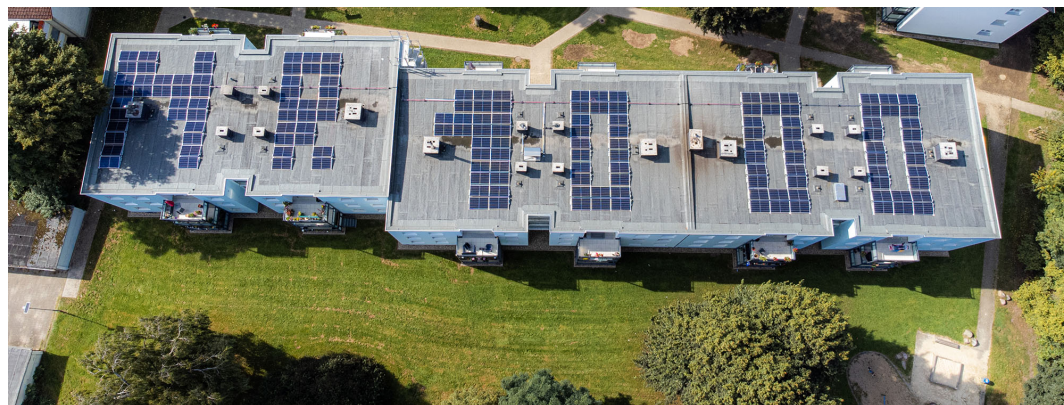
Vonovia Immobilienkonzern: das 1'000. Solardach (Quelle: Vonovia/Simon Bierwald)
