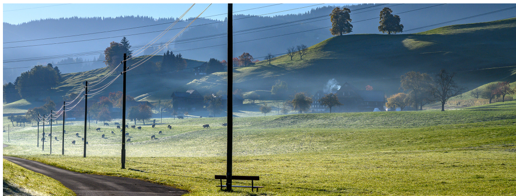
Strom- und Telefonleitungen als essenzielle Infrastruktur (Foto: Andreas Busslinger, Kanton Zug)
