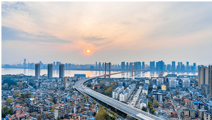
Le pont de Yingwuzhou à Wuhan sur le fleuve Yangtze
