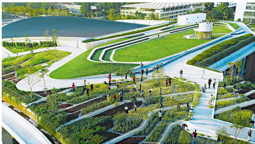
Le plus grand toit végétalisé d'Asie, réalisé par Firestone Building (photo : LANDPROCESS / Panoramic Studio)
