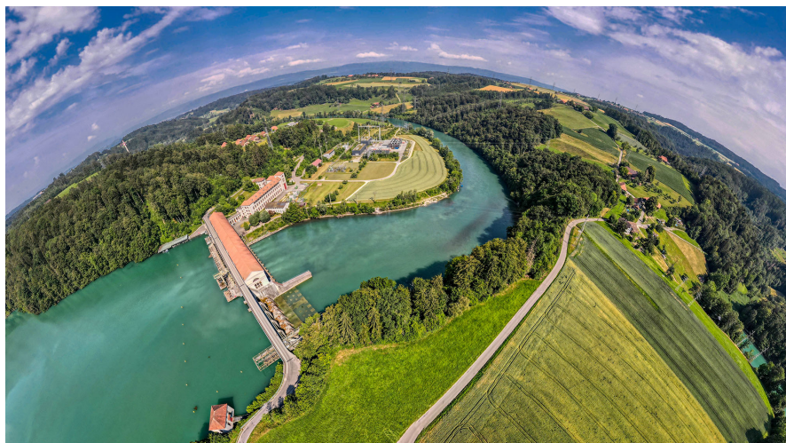
Centrale hydroélectrique de Mühleberg de BKW Energie AG
