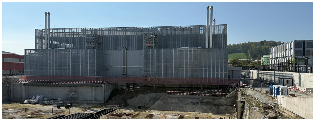
« Site hyperscale » ZRH2 du Green Data Center à Dielsdorf (Image : courtoisie)
