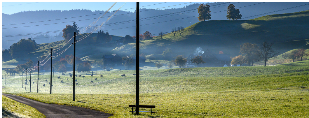
Les lignes électriques et téléphoniques, des infrastructures essentielles (Photo : Andreas Bussinger, canton de Zoug)
